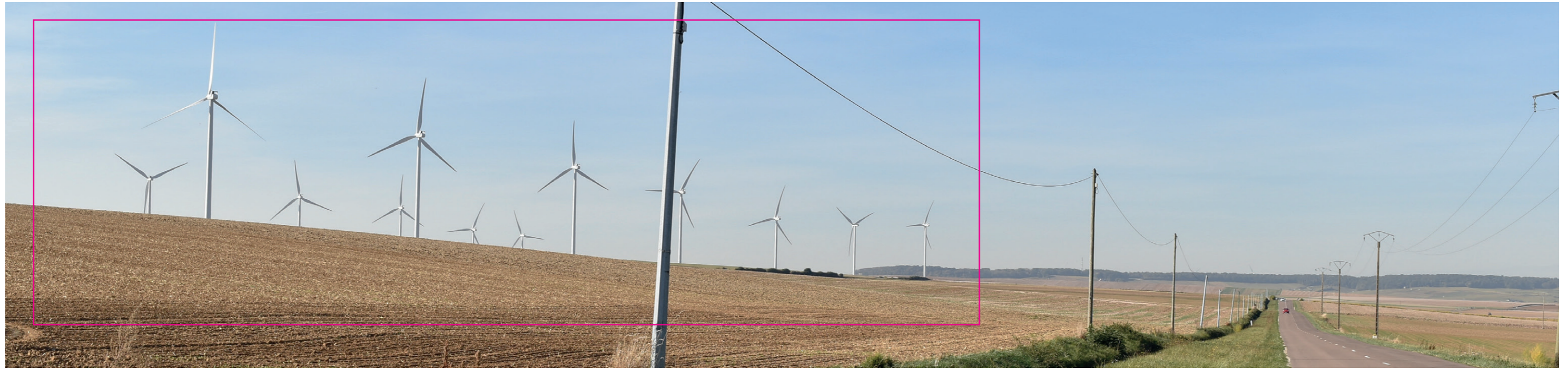
Potangis - Parc de la croix Benjamin, 14 éoliennes, Eneria, Akuo Energy Un parc situé à 2,5km du pied de cuesta, qui occasionne une rupture d'échelle avec le relief.
